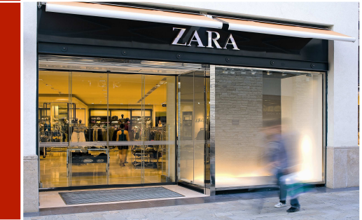
Bir Hareketli Br Sabit Kanatlı Yana Kayar Fotoselli Kapılar
