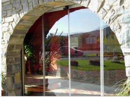
İki Hareketli İki Sabit Kanatlı Yana Kayar Fotoselli Kapılar
